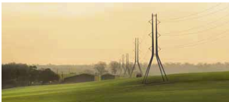
Þessi grunngerð af háspennumöstrum var hugsuð út frá þörf þýskra bænda til að geta unnið vandræðalaust með tæki sín og tól undir möstrunum.
