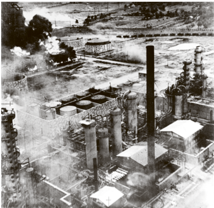
Þýsk olíuvinnslustöð eftir loftárás í seinni heimsstyrjöldinni árið 1943.
