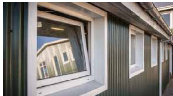
Gluggarnir sem opnast inn á við að ofan hafa læsingu efst á faginu svo dýrin ná ekki til þeirra. Þeir henta því afar vel í gripahús.
