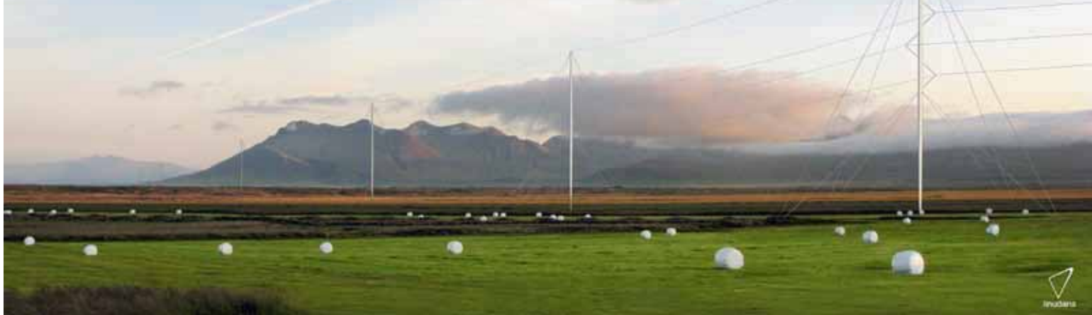
Ein af grunngerðum af háspennumöstrum úr trefjastyrktu plasti í íslensku umhverfi.
